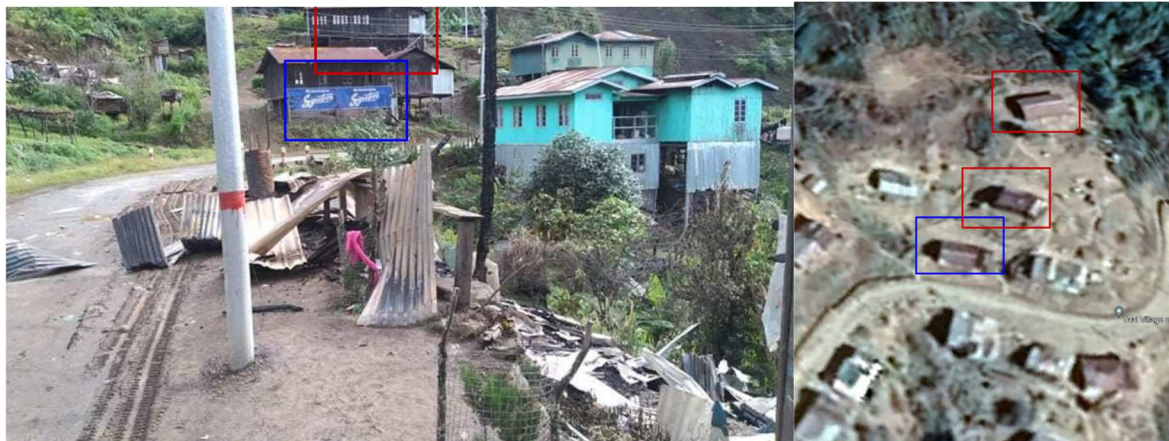
Figure 12: A structure is destroyed in Taal (တာရီ), Falam (ဖလမ်း), Chin (ချင်းပြည်နယ်).
